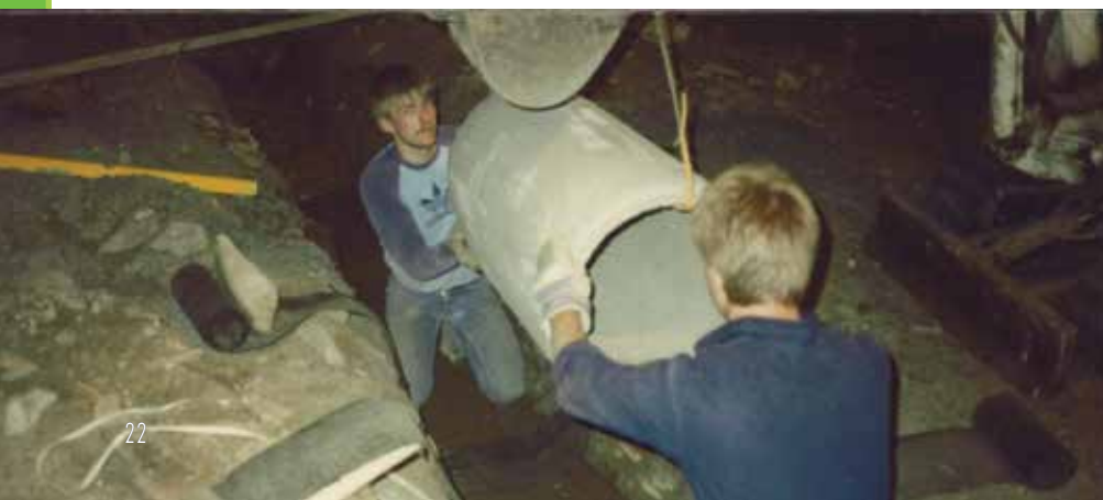
1989 Einbau Lüftung. Foto: © Central-Lichtspiele
