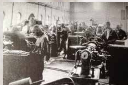
Zwangsarbeiter bei Siemens während des Krieges. Foto: © Hans-Erich Viet
